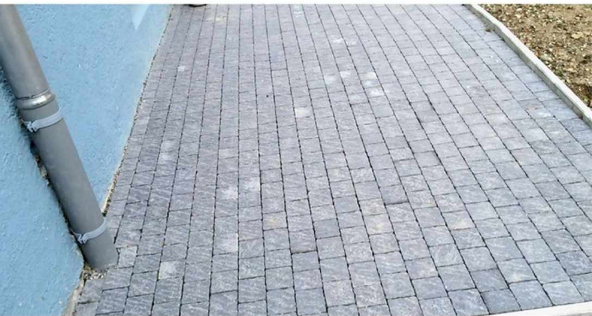
Eingang mit Tegula Verbundsteinen
