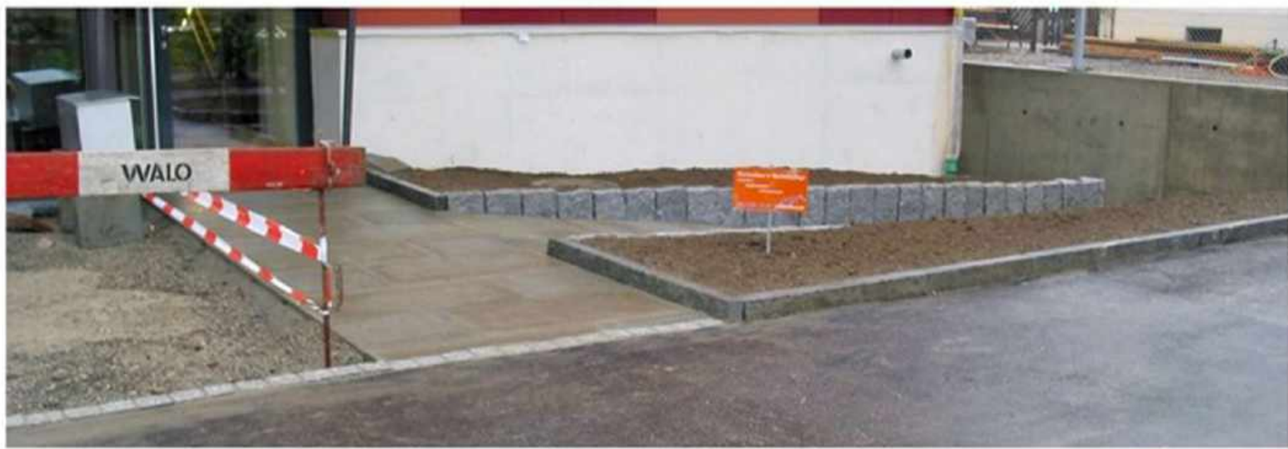
Eingangsbereich während der Bauarbeiten
