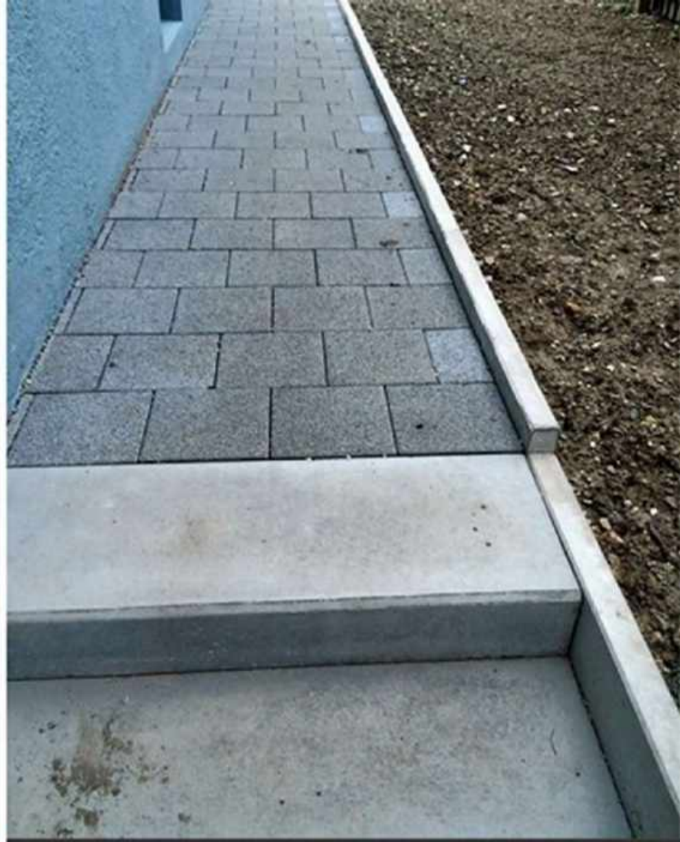
Stellriemen stützen die Treppe und den Weg ab
