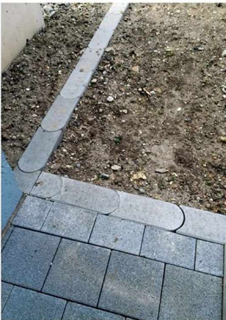
Rasenkantensteine trennen den künftigen Rasen und das Beet
