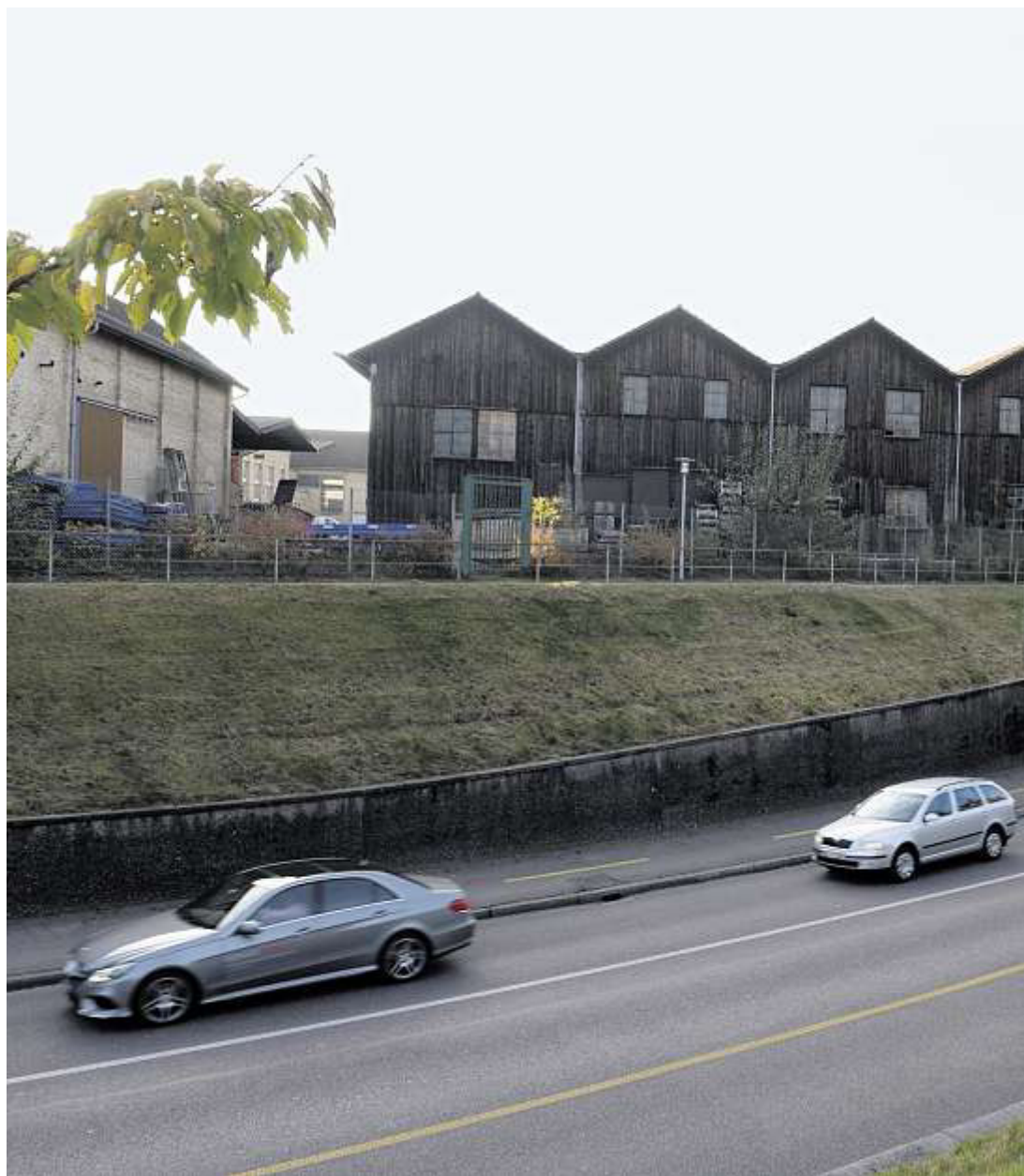
Die Holzbaracken bleiben vorerst. Der Gemeinderat hat die Arbeiten an der letzten Etappe des Eulachparks auf der gegenüberliegenden Seite der Seenerstrasse zusammen mit anderen Investitionen aufgeschoben. Heinz Diener
