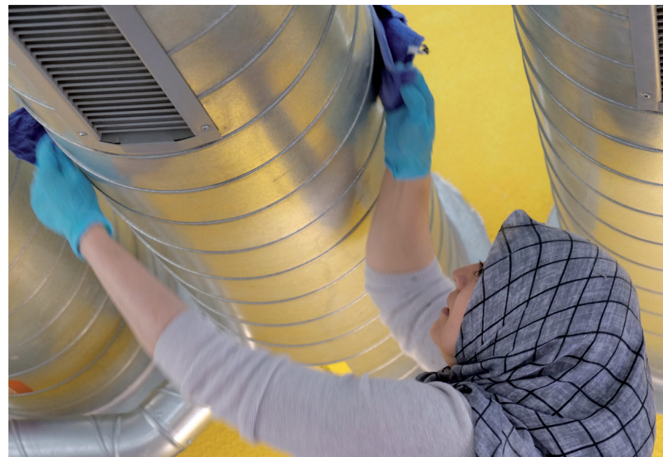
Rundum professionelles und exaktes Arbeiten, selbst in höchster Höhe!
