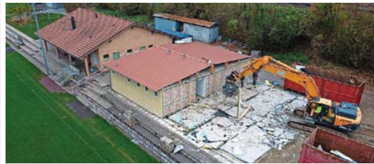
Die alten Raumcontainer werden abgebaut, um Platz für den Neubau zu schaffen. so
